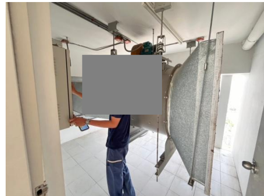
รูปที่ 2-39 ทำความสะอาดแผ่นกรองอากาศส่วนกลาง
