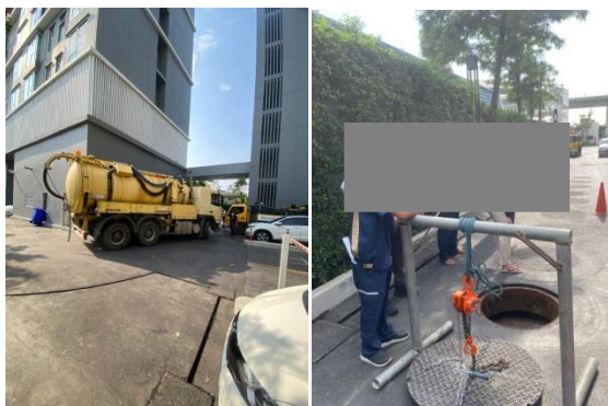
รูปที่ 2-46 ประสานงานกับสำนักงานเขตบางพลัดเข้ามาสูบตะกอนของระบบบำบัดน้ำเสีย
