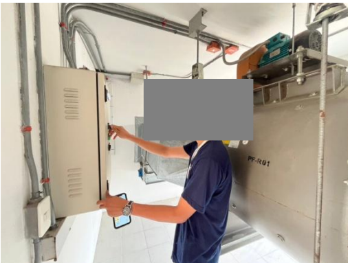
รูปที่ 2-39 ทำความสะอาดแผ่นกรองอากาศส่วนกลาง
